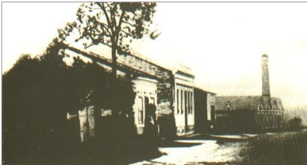
Figura 2.1-10 Caminho entre a Vila de São Bernardo e a Estação, antigo Caminho do Pilar, atual Rua Coronel Oliveira Lima. Ao fundo, a Fábrica de Cadeiras Streiff. 1890
