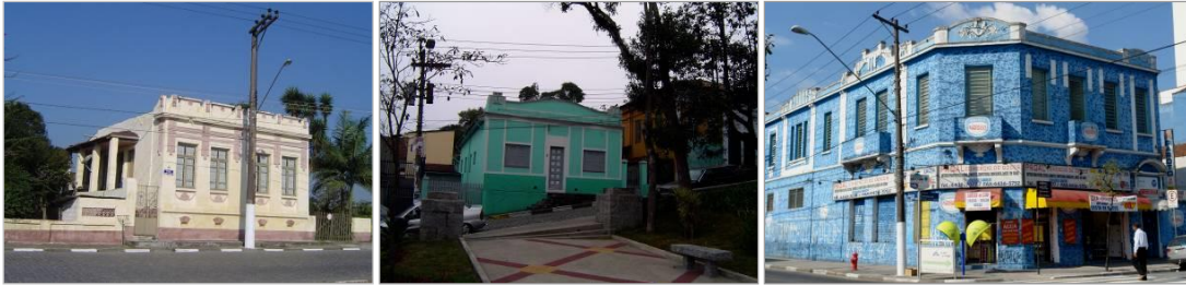
Imagem 2. Permanências na paisagem de imóveis térreos e assobradados quase centenários identificados em Rio Grande da Serra, Ribeirão Pires e Santo André.
